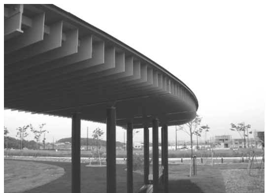
この公園内の四阿はスチールバンドが連続した幾何学的なデザインであり、構造的には無駄であるが、デザイナーの主体性が発揮されている。
